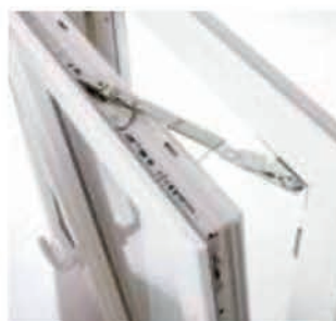
Détail système oscillo-battant
