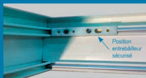
Gâche inox pour condamnation bidirectionnelle
