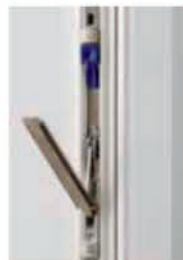
Verrouillage du vantail secondaire.
