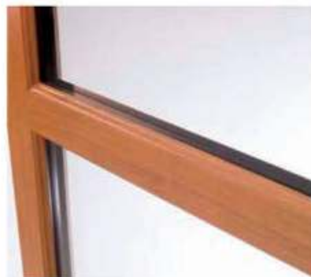
Petits bois mortaisés séparant chaque carreau.
