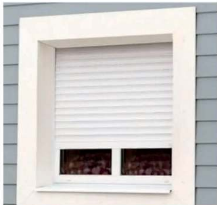
2 tailles de coffre : 165 et 180 mm extérieur
