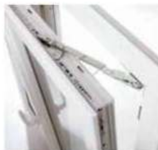
Détail système oscillo-battant
